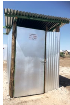
建設後のトイレ
