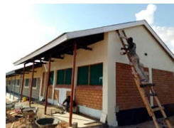
訓練生のISSBブロックを使って建設された女子高等学校の教室
