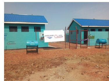
完成した学校のトイレと手洗い場
