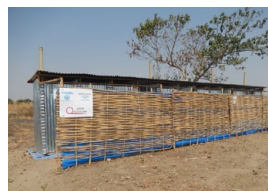
Vickyが監督するキャンプのトイレ建設。
