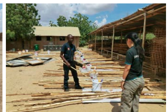
簡易住宅を建設するための資材
