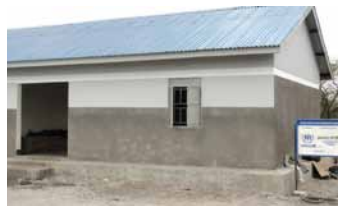
村に唯一の保健所を新設
