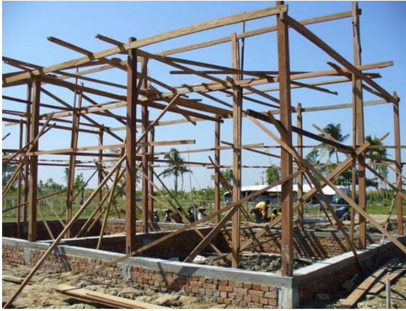
建設中の校舎
