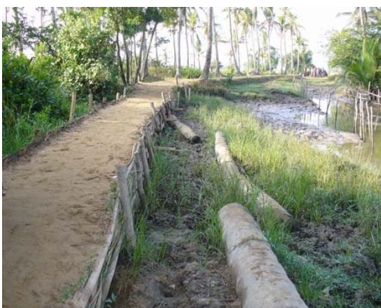
上：修復した村内道路
