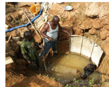
建設中の井戸
