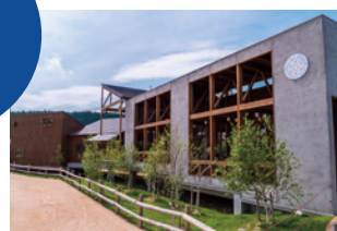
マルクトプラッツの外観
