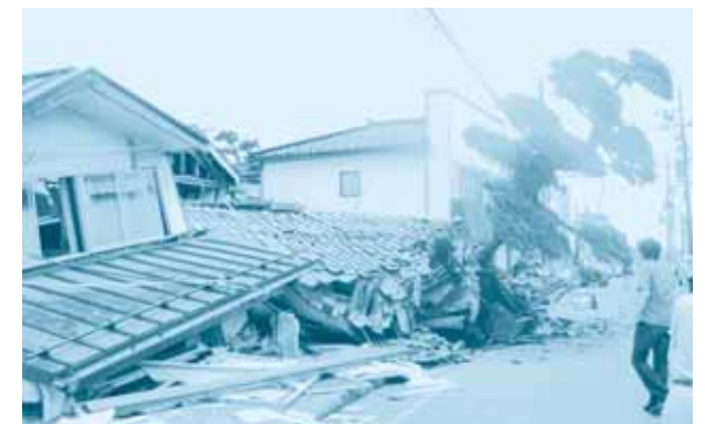
地震で倒壊した家屋[ 新潟 ]
