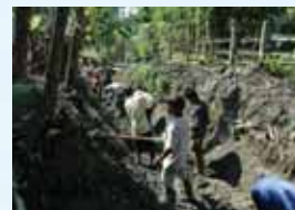
側溝の瓦礫や泥の撤去を行う住民たち
