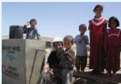
イラク北部の村に設置した給水施設
