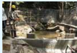
グラビティ給水システムによる簡易水道の建設
