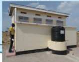
学校に建設したトイレと手洗い場
