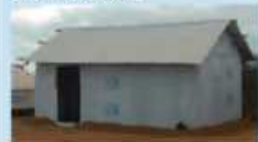
PWJが建設した仮設住宅
