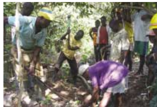
コノ地区の簡易水道建設
