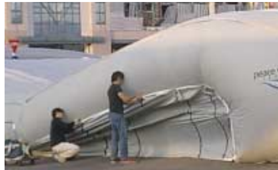
国内でのバルーンシェルター初使用(2004年)
