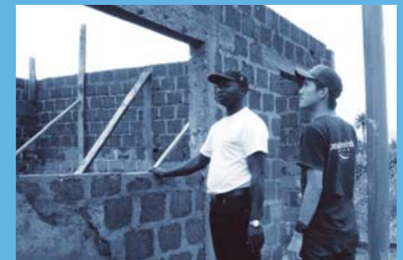
建設中の学校を確認する備中哲人（右）
