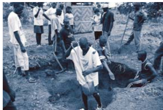
現地の人たちも参加したトイレ建設の作業
